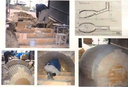
⑤ 1999年4～6月 穴窯の築窯工事
